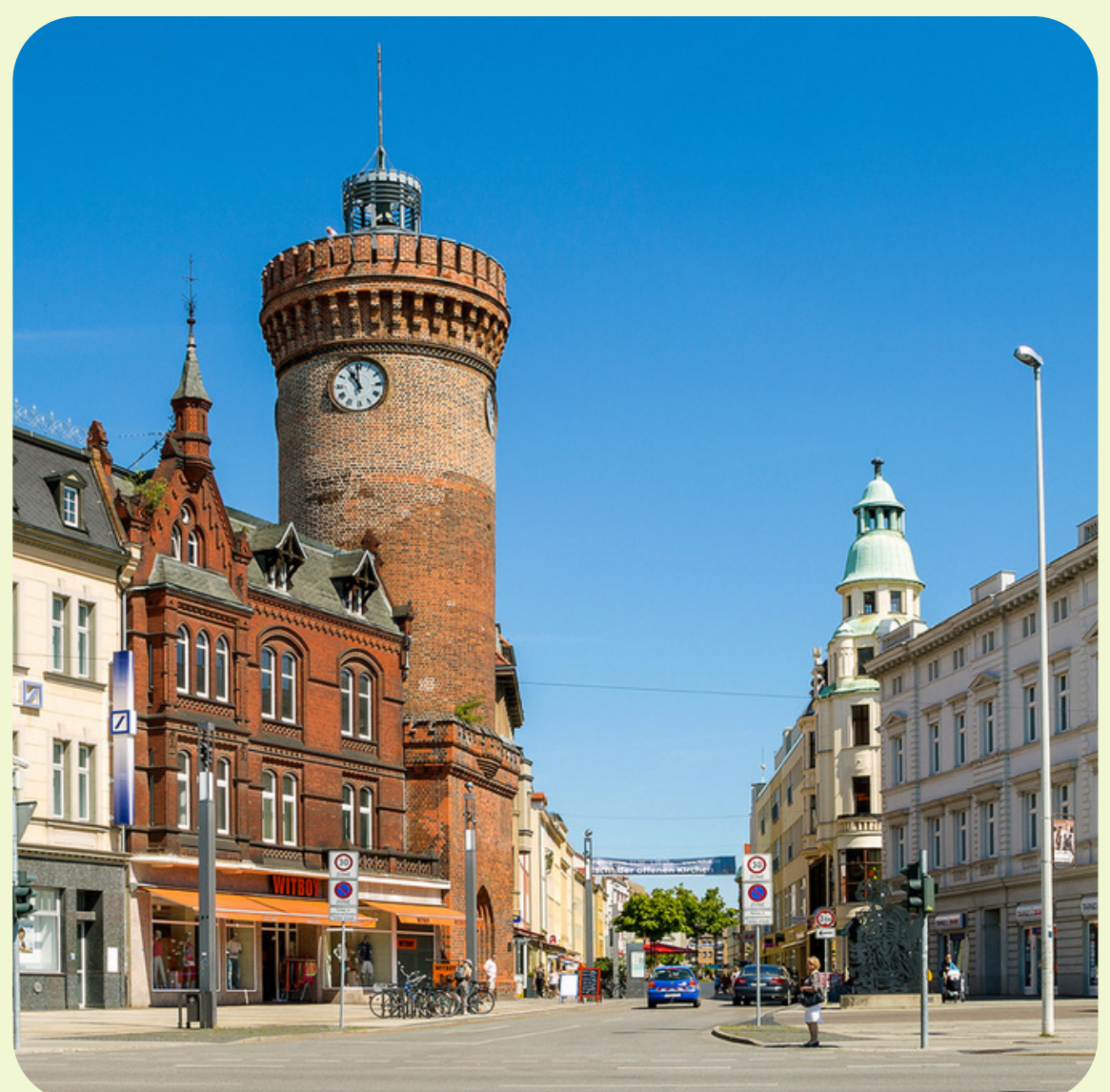
Der Spremberger Turm als Eingang zur Spremberger Straße
